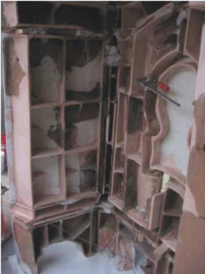
Abb. 2 Wie es darunter aussieht: Die ergänzten Kacheln mal probeweise aufgebaut. – Foto: Udo Arndt, 2007
