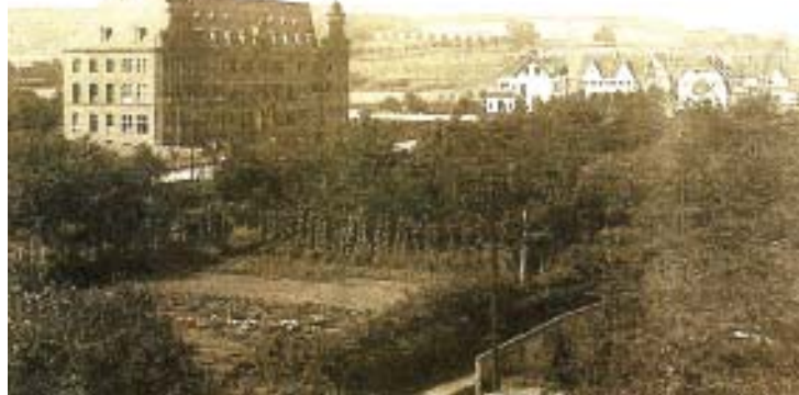
Abb. 8 Blick über den späteren Bauplatz des Rathauses auf das Alumnat; mit dem Jean-Schmitz-Ensemble im Hintergrund (nicht datiert; um 1910), - Quelle: Hist. Archiv der Stadt Brühl
